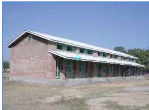
写真⑥（右）建設された新しい校舎
