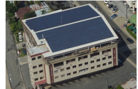
太陽光発電(パシフィックコンサルタンツ／パラオ)
