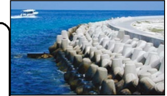
護岸壁の建設支援 (適応案件の例)
