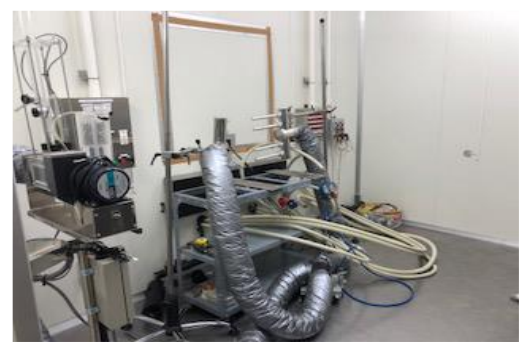
空調試験設備内部(ハノイ) (20 機器 / 月の試験を実施)
