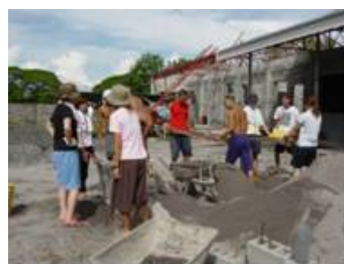
施設の建設作業
