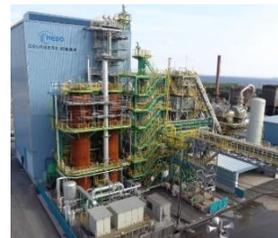
12m<sup>3</sup> 小規模試験高炉(水素還元)
